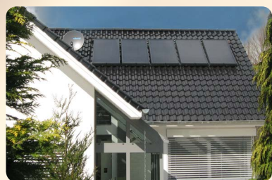
Ziegel-Aufdachmontage tecSol UP-V
