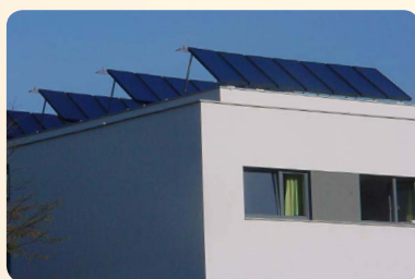
Aufdachmontage tecSol UP-V
